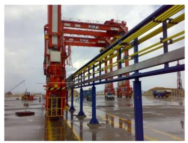
BU: Der Stromabnehmerwagen, der in einer Stahlkonstruktion geführt wird, übertragen die Energie von den Schleifleitungen auf den RTG Kran.
